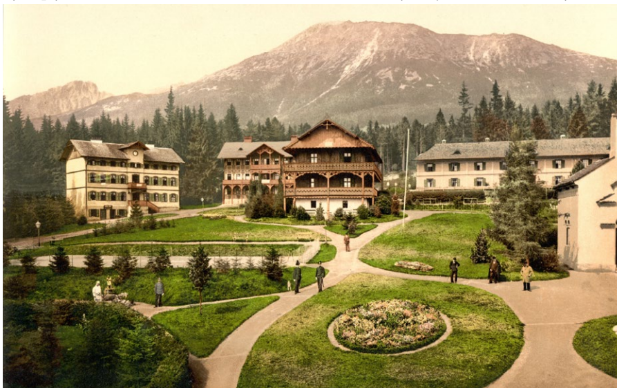
Na historickej fotografii pohľad na Starý Smokovec. Dodnes sa zachovala kaplnka, Švajčiarsky dom a Bellevue, kde aktuálne prebiehajú stavebné práce.
